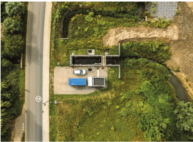
Werken aan de sluis in Bekkevoort.
