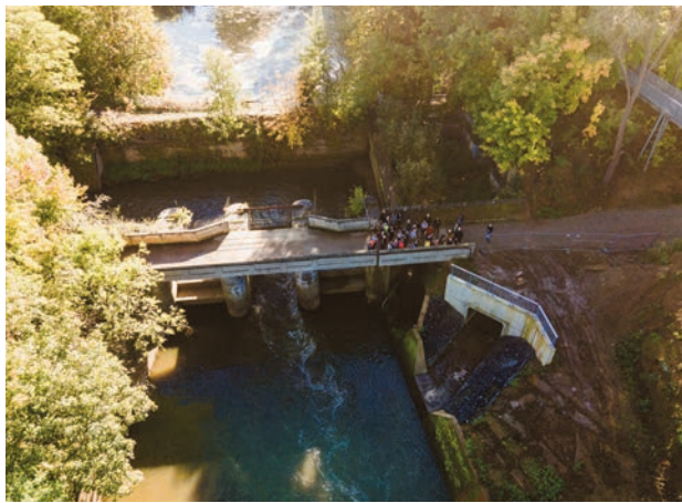
Renovatie stuwconstructie 'Grote Steunbeer' aan de Saspoort in Diest.
